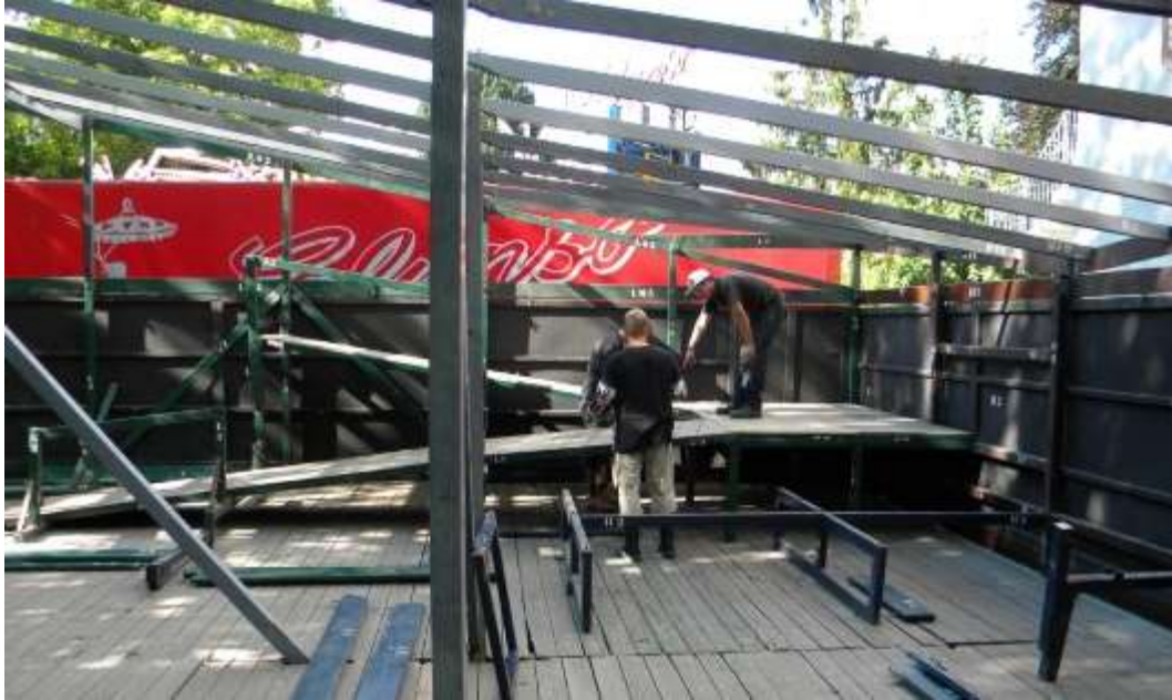
Drehabsatz für die Gondeln (Wagen) bei bidirektionaler Abfahrtsbahn. Wiener Prater-Geisterbahn.
