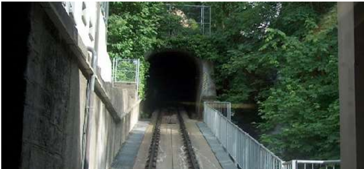
Mühleggahn-Tunnel, 9000 St. Gallen
