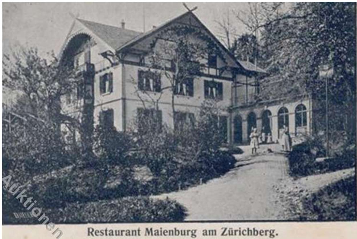
Ehem. Rest. Maienburg, Forsterstr. 40, 8044 Zürich (1904)
