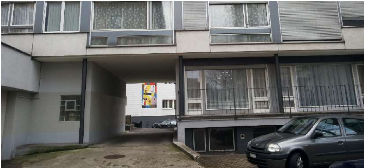
Konkordistraße, Lämmli Brunnenstr. 44, Sägegässlein, 9000 St. Gallen
