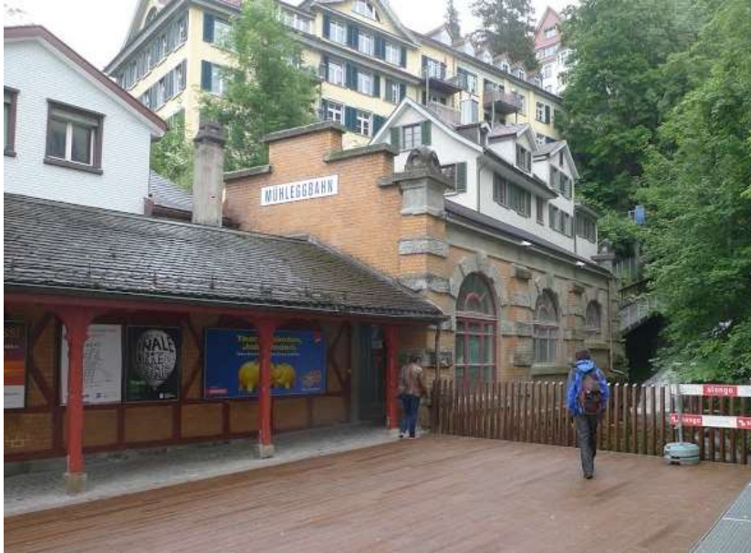
Talstation Mühleggbahn, 9000 St. Gallen
